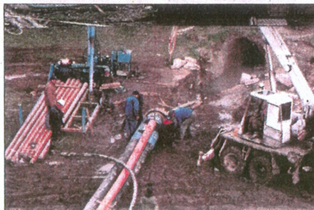
Po pilotnom vrte mal mikrotunel priemer 200 milimetrov, postupne ho zväčšili až na 1 meter.
