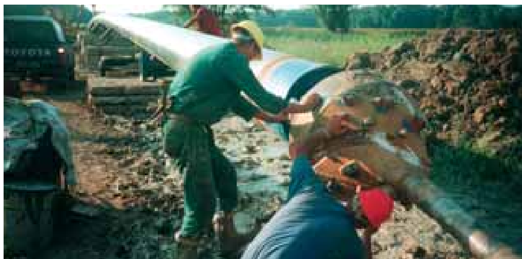
Zaťahovacia hlava s protirádiusom oceli. VTL
