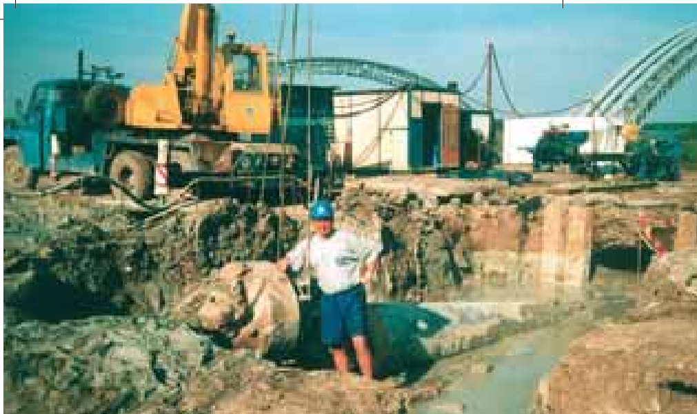
Zaťahovacia hlava s potrubím po 5 hodinách zaťahovania na druhej strane rieky
