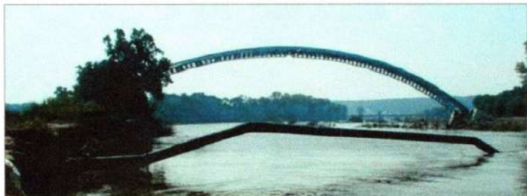
Foto 1 - Vyplavené VTL potrubie DN 500 PN 25 uložené do výkopu na prechode Vltavy pri Veltrusoch počas povodne v roku 2002
