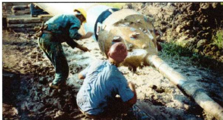
Foto 6 Reál zaťahovania potrubia VTL plynovodu s 711x11 mm dlhé 300 m pod riekou Moravu
