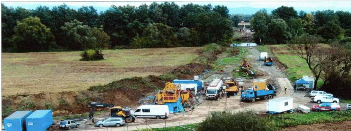
Foto 9 Zariadenie staveniska VTL plynovodu DN 1000 mm dĺžky 350 m
