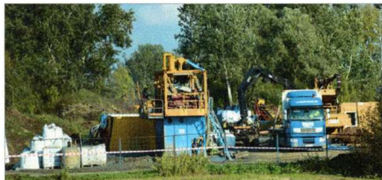
Foto 3 - Veľkopriemerové vŕtanie HDD 135 mm so separáciou výplachu pod Laborec
