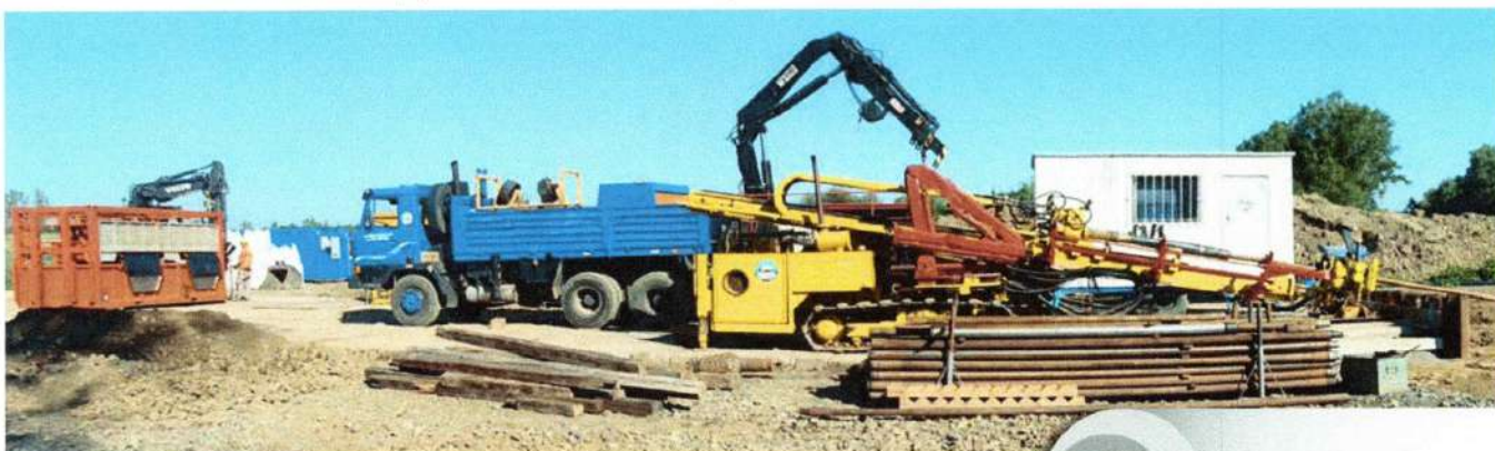
Foto 10 Vŕtací stroj HDD s ťažnou silou 40 ton
