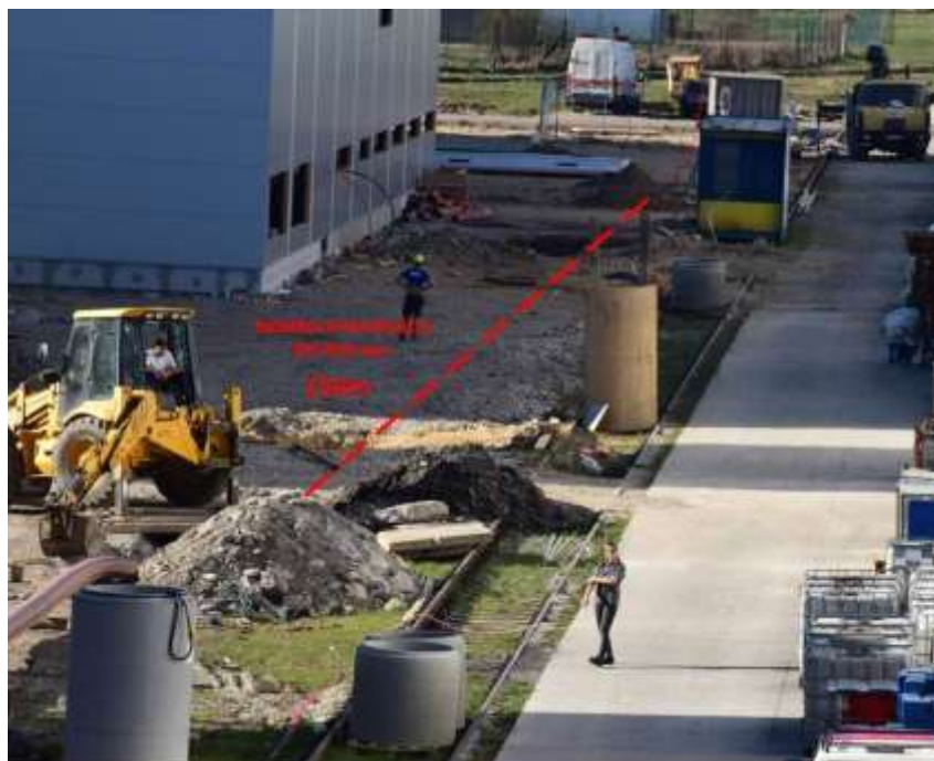
Obr.3. Splašková kanalizácia DN 300
