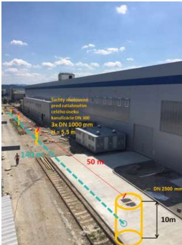
Obr.4. Šachty zhotovené pred zatahnutím celého úseku 150 m kanalizácie DN 300.
